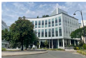
Rueil Malmaison Siège (Ile-de-France - France) 350 personnes
